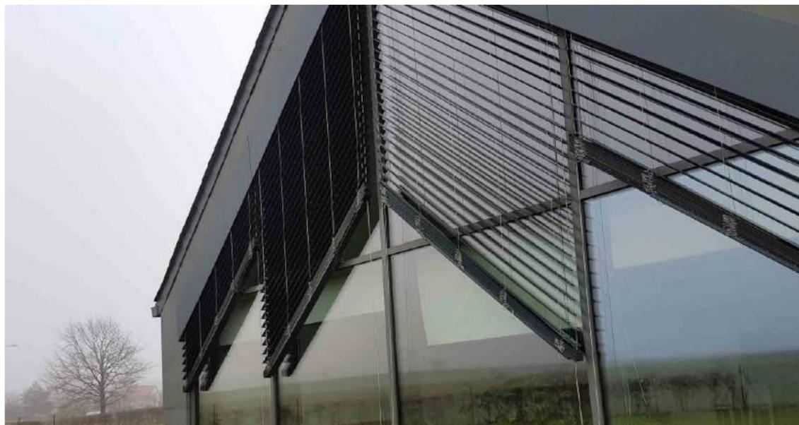
Schrägraffstores sind innovative Sonnenschutzsysteme, die sich durch ihre flexible Anpassungsfähigkeit an verschiedene Fensterformen und Fassadengeometrien auszeichnen. Diese speziellen Raffstores sind besonders für geneigte oder asymmetrische Fensterflächen geeignet und bieten eine effektive Lösung, um Sonnenlicht zu regulieren und Blendung zu vermeiden.
